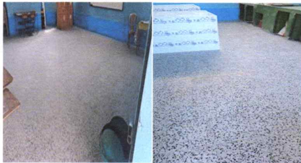
Foto 3: Piso granito colocado
