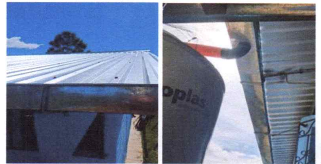
foto 4: Canales y bajadas de agua pluvial instalado
