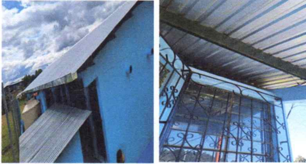
Foto1: Cubierta de lámina instalada
